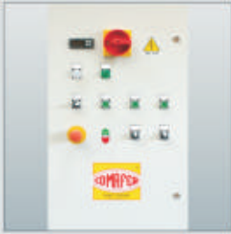
IP55电控柜和 EATON电气部件
